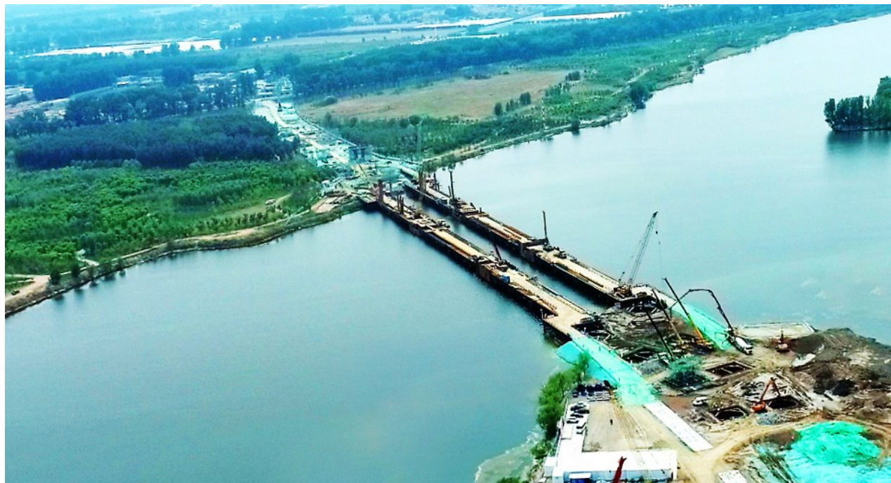
图为厂通路潮白河大桥主桥水中作业项目施工现场。 李志新 图
