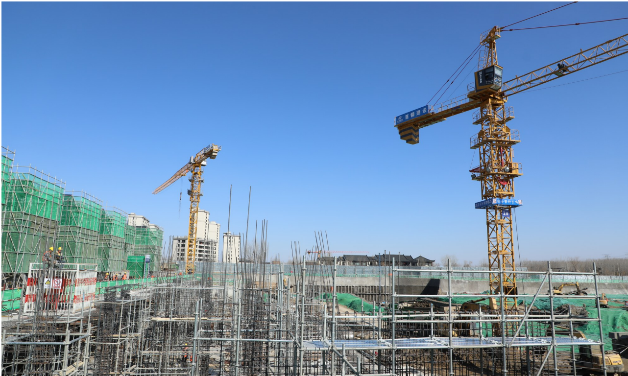
图为大厂域见颐和健康文化旅游产业园项目建设现场。 何赛 图
