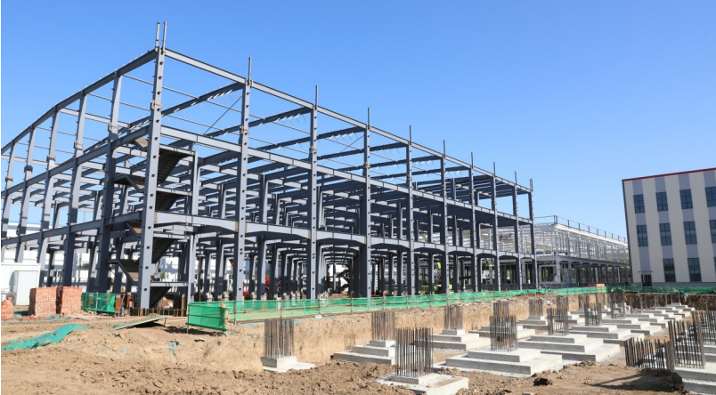
廊坊沃尔德超硬刀具及高端精密装备制造项目现场。
